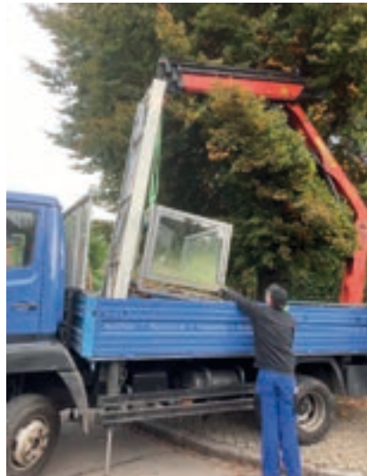
Abbau des alten Aufzug
